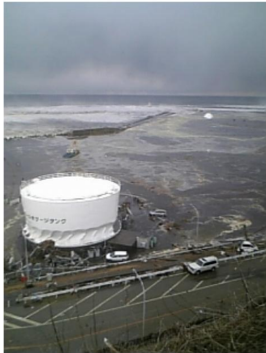
【福島第1原発 津波来襲状況 2011年3月11日 固体廃棄物貯蔵庫東側のり面(5号機の近傍(南側)から東側を撮影)＝東京電力提供】
