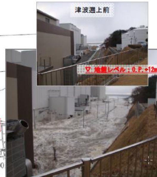
図III-2-11(a) 福島第二原子力発電所の津波による被害状況(1)
