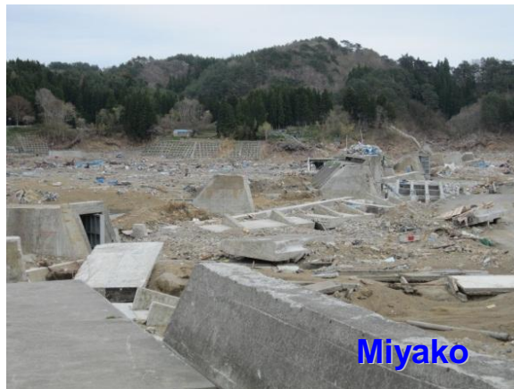
図III-1-16 岩手県宮古市田老地区及び普代村太田部地区における津波に対する防潮堤の堅牢の違いによる被害の明暗
