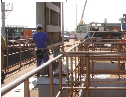
角落としの設置
