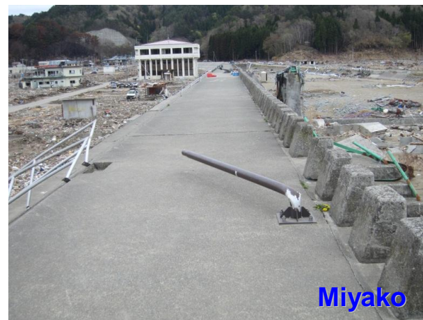
図III-1-15 津波による防潮堤及び施設の被害状況
