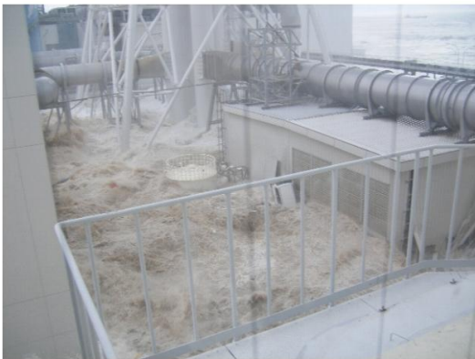
【福島第1原発への津波来襲状況 2011年3月11日 廃棄物処理建屋4階から北側を撮影】午後3時43分ごろ(2)＝東京電力提供】
