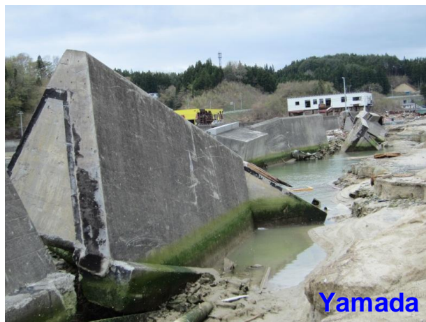
図III-1-15 津波による防潮堤及び施設の被害状況
