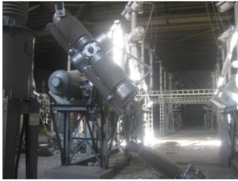
撮影：東京電力株式会社 H23.3.23
