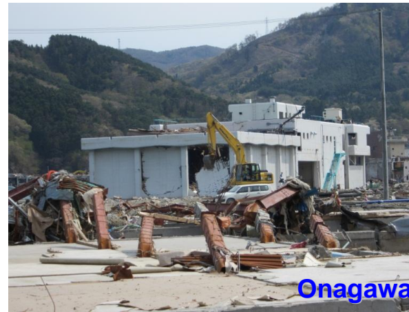
〔押し波の波圧による施設の薙ぎ倒し〕
