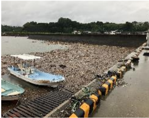
流木等が堆積した漁港
