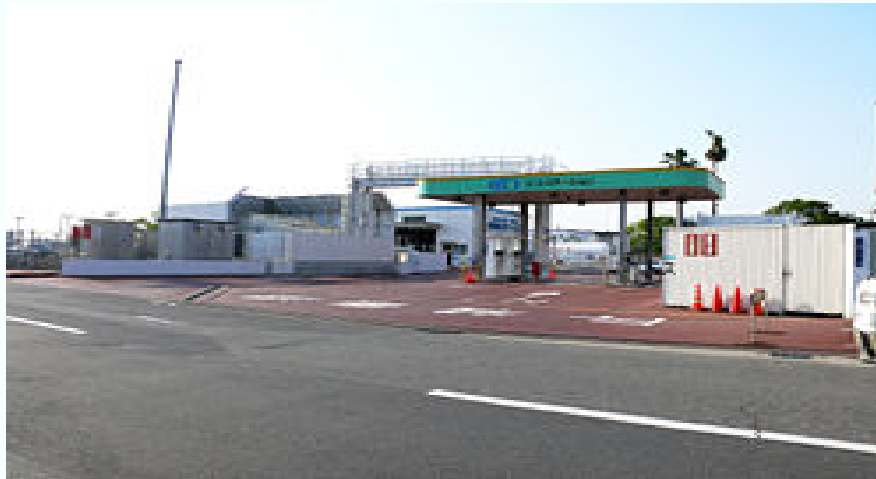
CNG自動車用スタンド
