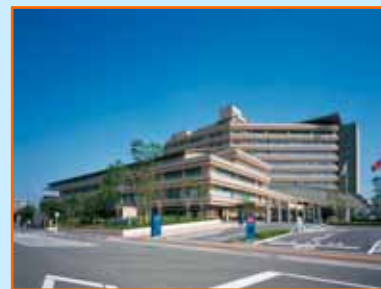
「公共建築物等の部門」 山梨県立中央病院
