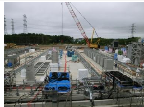
多核種除去設備設置エリア全景(7/21)
