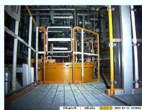
トラス室内の様子
