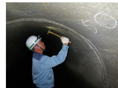
トンネル内部の点検状況 4
