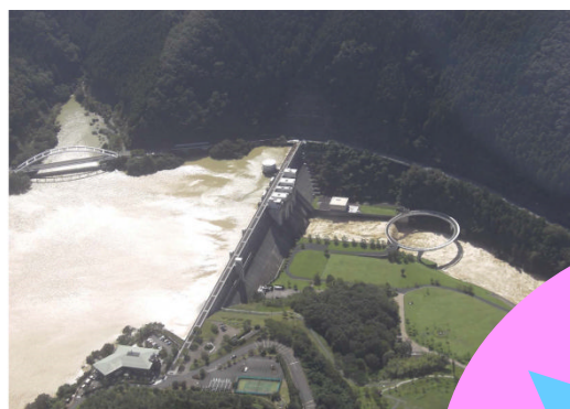
平成25年台風18号における日吉ダムの洪水調節(貯留)状況
