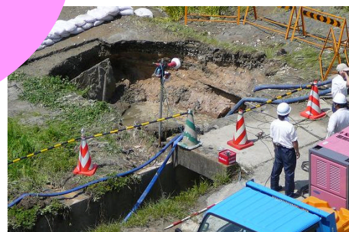
平成19年の福岡導水漏水出水時の応急復旧状況
