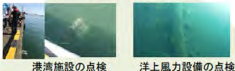
港湾施設の点検
