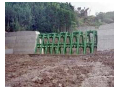
Barraje de contención de palizadas
