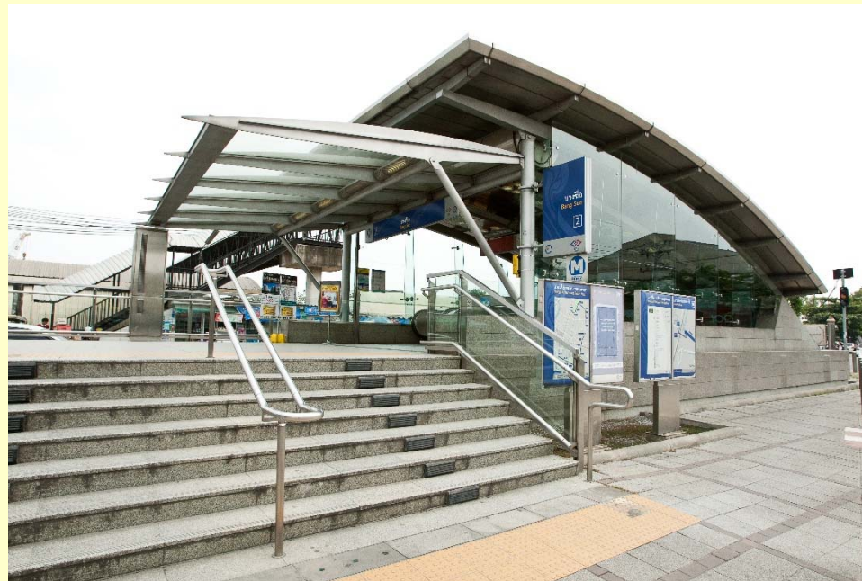
Subterráneo resistente a los desastres (Tailandia) (Foto: Shinichi Kuno / JICA)
