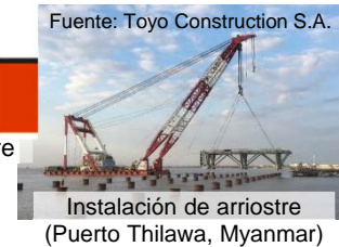
Imagen del método de arriostre
