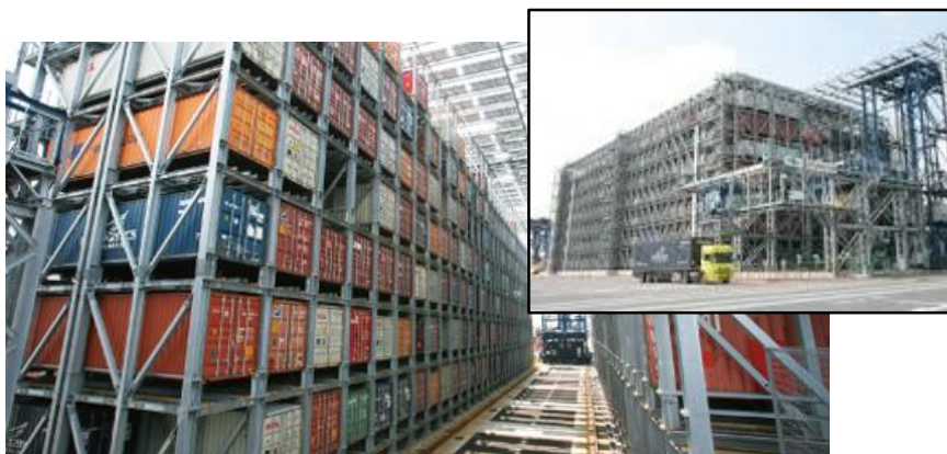
コンテナ立体格納庫(東京港大井ふ頭)
