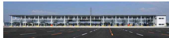
集中管理ゲート(名古屋港飛島ふ頭)
