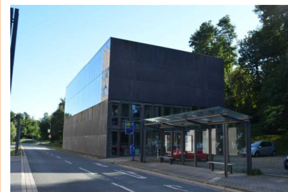
(新たに設置された事務所棟)
