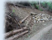
林業作業道の作道
