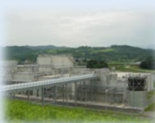
工場の排水処理施設
