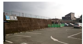
駐車場に設置
