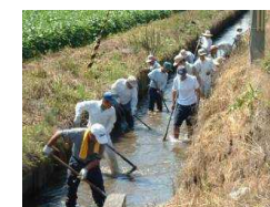
水路の泥上げ
