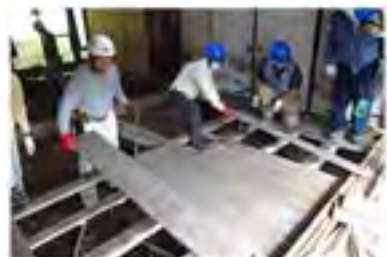
古民家リフォーム塾・床の張替え作業
