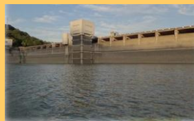
宮ヶ瀬ダム(神奈川県)
