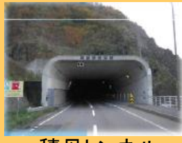
積丹トンネル(北海道)
