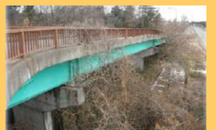
橋梁(茨城県・国総研)
