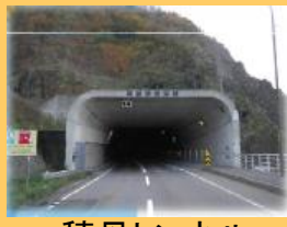
積丹トンネル(北海道)
