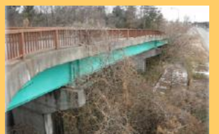
橋梁(茨城県・国総研)
