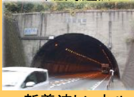
新善波トンネル(神奈川県)
