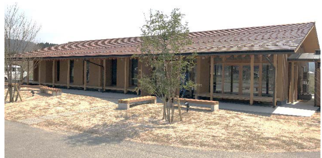
賀野地区サテライト拠点「エンガーノ富有」
