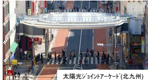
太陽光ジョイントアーケード(北九州)
