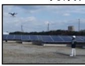
太陽光パネル点検
