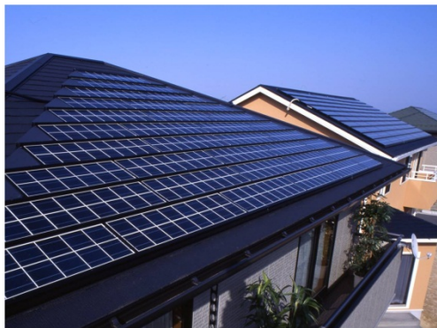
太陽電池発電設備であって出力50kW未満のもの
