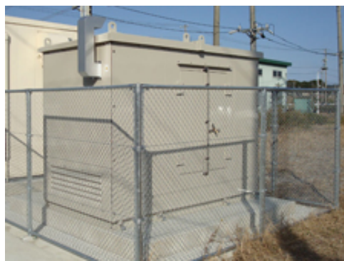
内燃力発電設備であって出力10kW未満のもの
