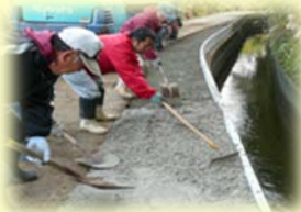
【水路の簡易補修】
