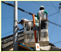
津波高表示テープの設置
