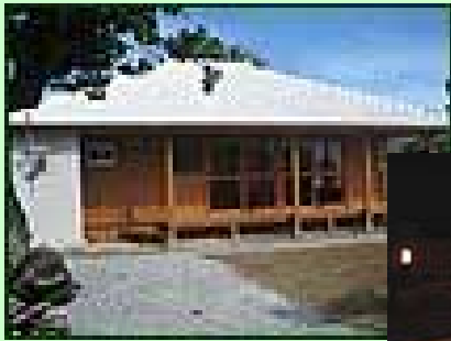
再生された古民家
