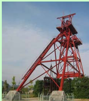
旧三井田川鉱業所 伊田竪坑櫓
