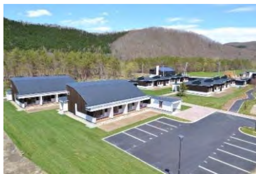
地域エネルギー自給システムと 高性能住宅で住みよい環境が整備 されている一の橋集住化住宅
