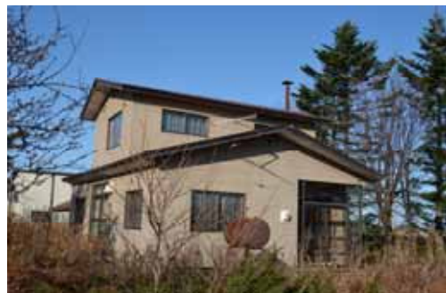
空き家の活用
