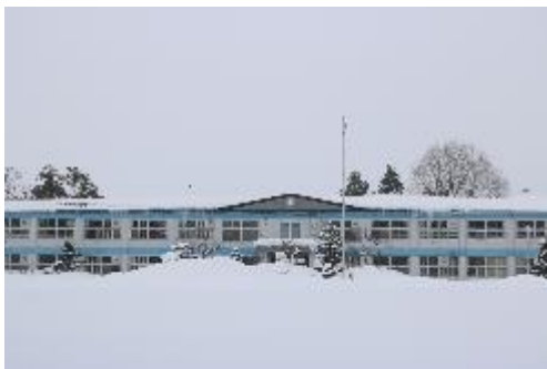
コミュニティカフェ開設予定の旧東川小学校
