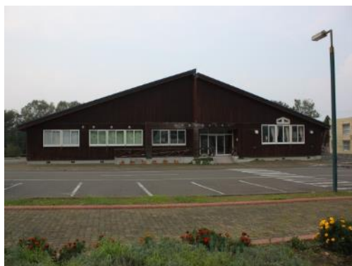
「小さな拠点」となる旧保健センター
