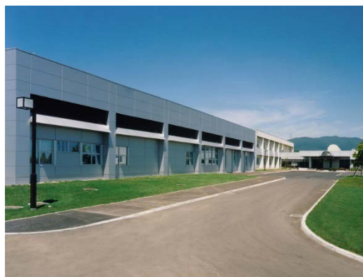
北海道立工業技術センター外観
