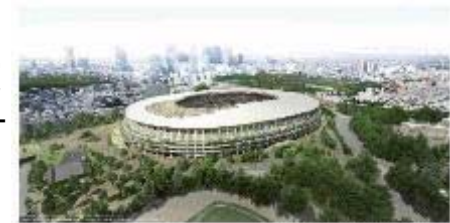
新国立競技場の建設状況(平成28年)
