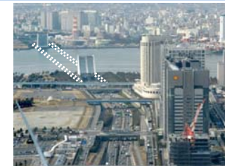
国道357号 東京港トンネル
