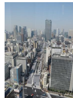
環状第2号線の整備
