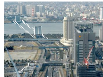
国道357号 東京港トンネル
