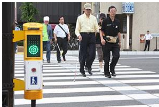
抱込型 @和歌山県和歌山市
