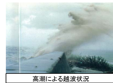
高潮による越波状況 高潮による越波により農地の浸水被害が発生
