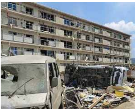
被害を受けた住宅と大破した自動車 (平成24年5月6日:茨城県つくば市) 写真提供:気象庁
