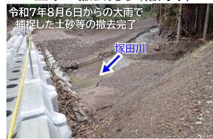
塚田川 仮設堰堤に堆積した土砂の撤去完了(輪島市)
