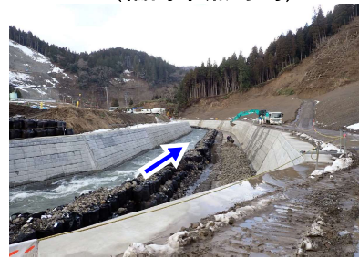
河原田川 護岸の本格的な復旧 (輪島市熊野町)
