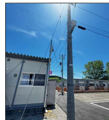
仮設住宅への整備
