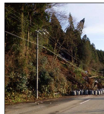
ケーブルの復旧
