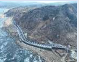
国道249号輪島市千枚田工区
