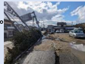
液状化被害（内灘市街地）
