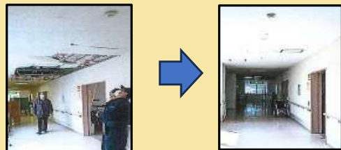
【介護施設の復旧の様子】
