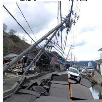
地震による被害
