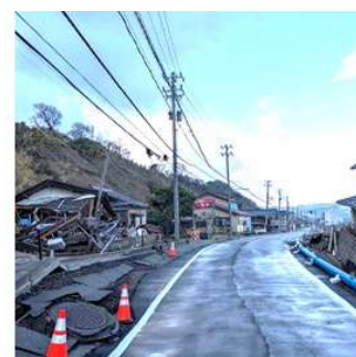
地震からの復旧
