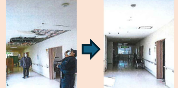
介護施設の復旧の様子
