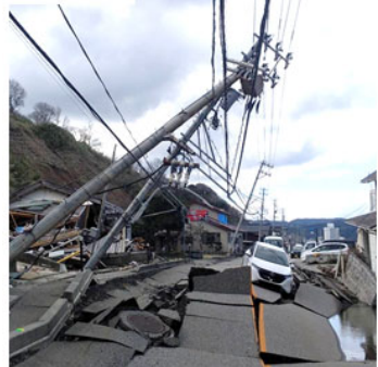
地震による被害
