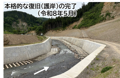
河原田川 護岸の本格的な復旧 （輪島市熊野町）
