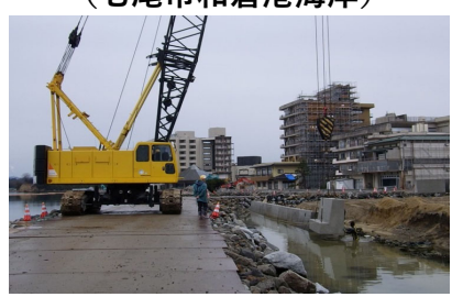
新たに製作した護岸の設置 （七尾市和倉港海岸）
