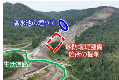
河原田川 恒久対策の施工 （輪島市市ノ瀬町）
