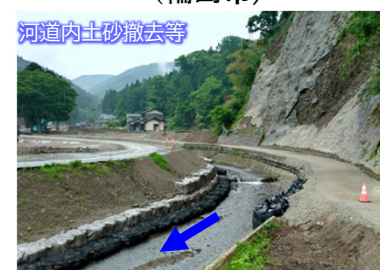
塚田川 応急安全対策完了 （輪島市）
