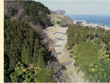
復旧した山腹崩壊現場
