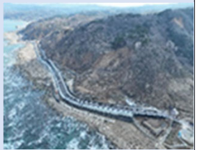
国道249号輪島市千枚田工区
