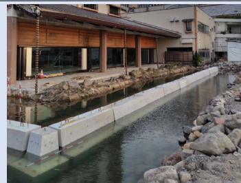
新たに製作した護岸の設置(和倉港海岸)
