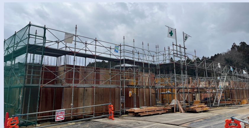
七尾市・小丸山団地で開始された工事
