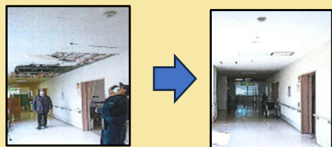
【介護施設の復旧の様子】
