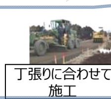
検測と施工を繰り返して整形
