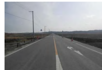
撤去後(平成28年3月)
