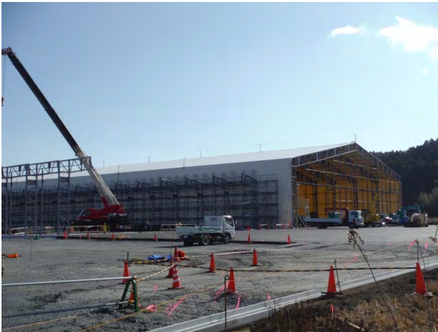
受入・分別施設予定地における仮設建屋設置等工事
