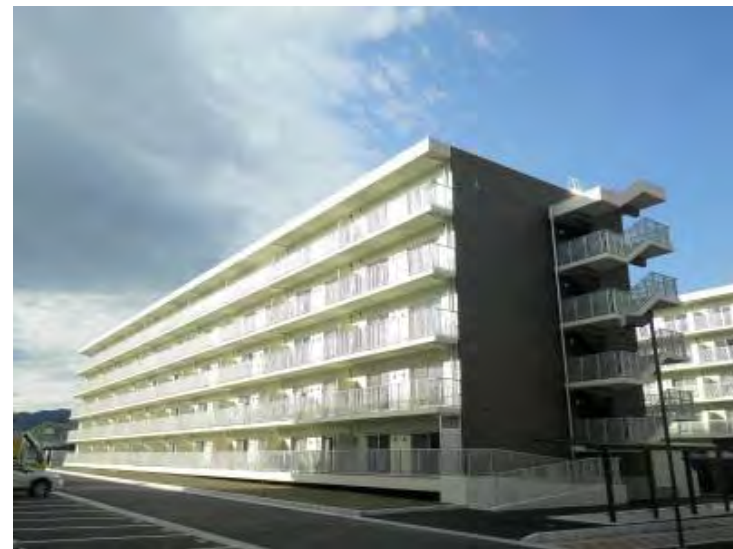
県営復興公営住宅(南相馬市南町団地)
